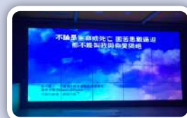
◀ 安和福氣教會新建堂數位顯示整合方案施工過程
